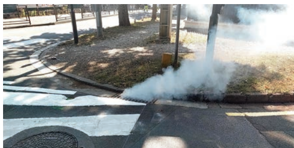
Essais à la fumée pour repérer de mauvais branchements du réseau d'eaux pluviales vers celui des eaux usées.
