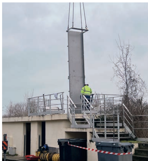
Remplacement d'un dégrilleur, ouvrage qui permet de retenir les déchets solides transitant dans les eaux usées.
