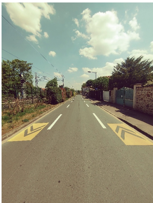
Chaussée à Voie Centrale Banalisée rue Paul Leplat à Marly-le-Roi
